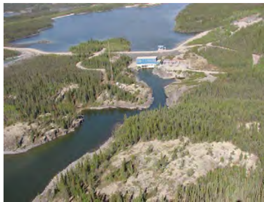
Snare Forks (SK) Power Plant.
