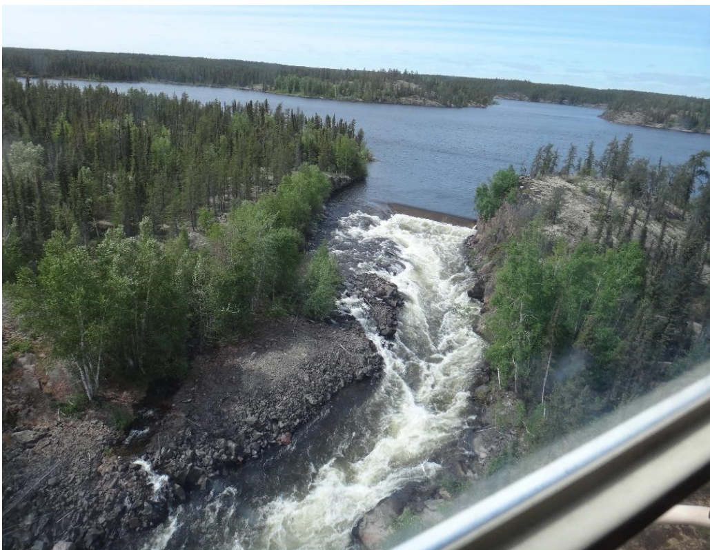
Figure D.34: Taltson Spillways 2
